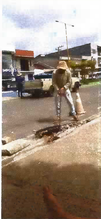
Figura 04: Manutenção em rede de esgoto/água.
