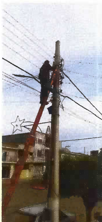
Figura 01: Manutenção na iluminação pública.
