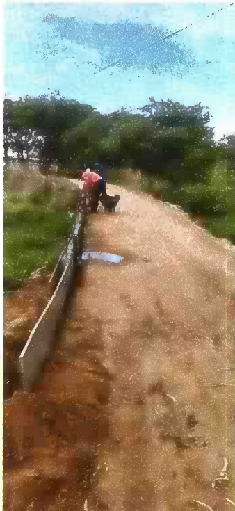
Figura 04: Manutenção em passagem molhada
