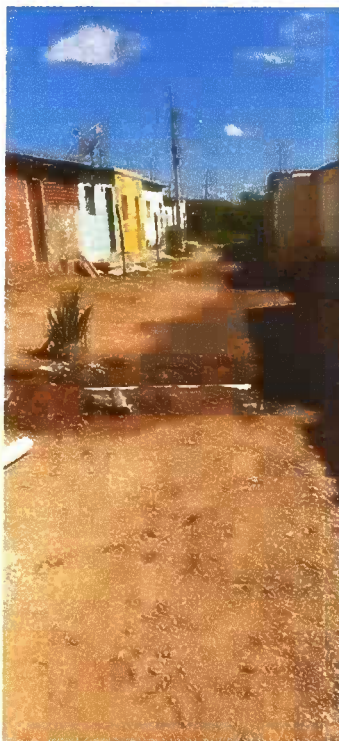
Figura 04: Manutenção em rede de esgoto/água.
