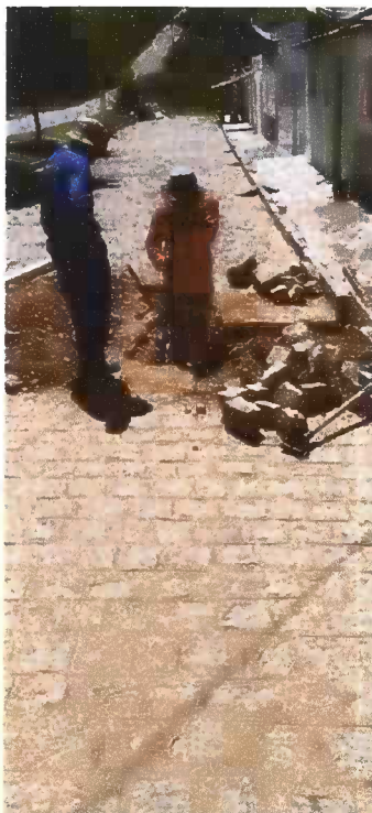
Figura 04: Manutenção em rede de esgoto/água.
